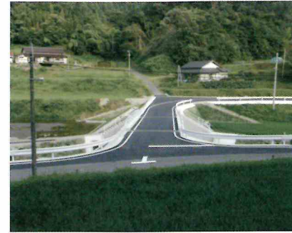
市道山崎線道路改良工事
