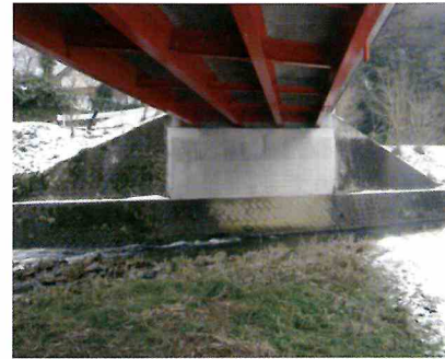
佐田八神線柄栗橋防災安全交付金 (橋梁修繕) 工事
