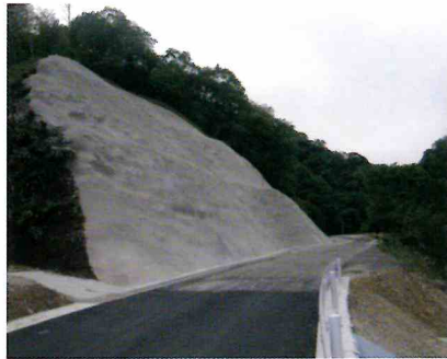
宮内掛合線穴見工区 社会資本整備総合交付金(改良)工事
