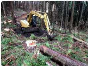
作業道の開設
