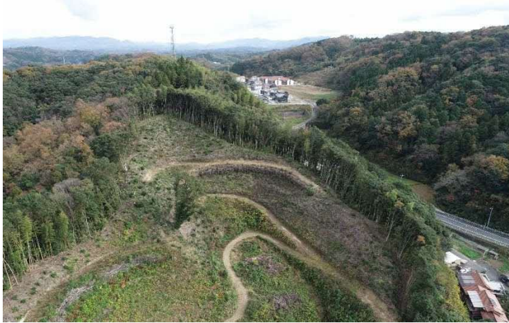
ドローン撮影 主伐後画像
