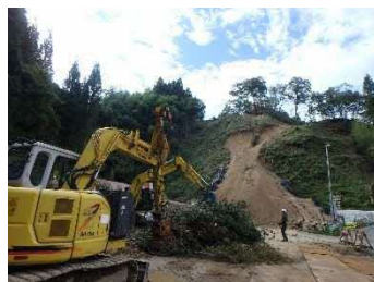
伐採作業（建設工事）
