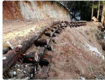
作業道の開設
