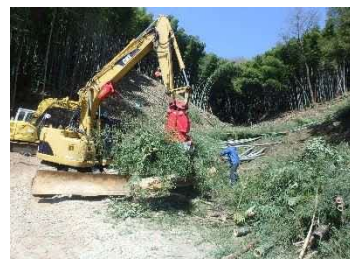
伐採作業（建設工事）
